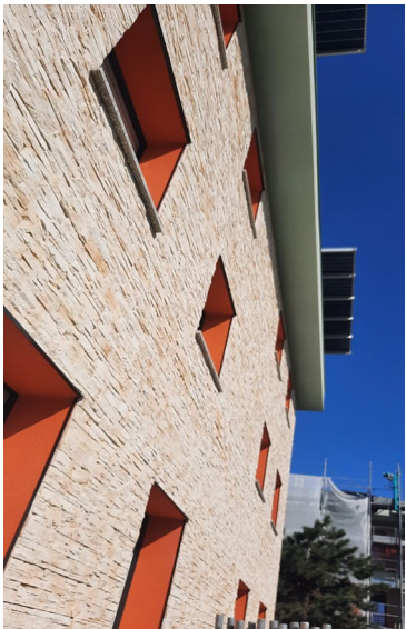
Coibentazione esterna con aggiunta di massa termica
