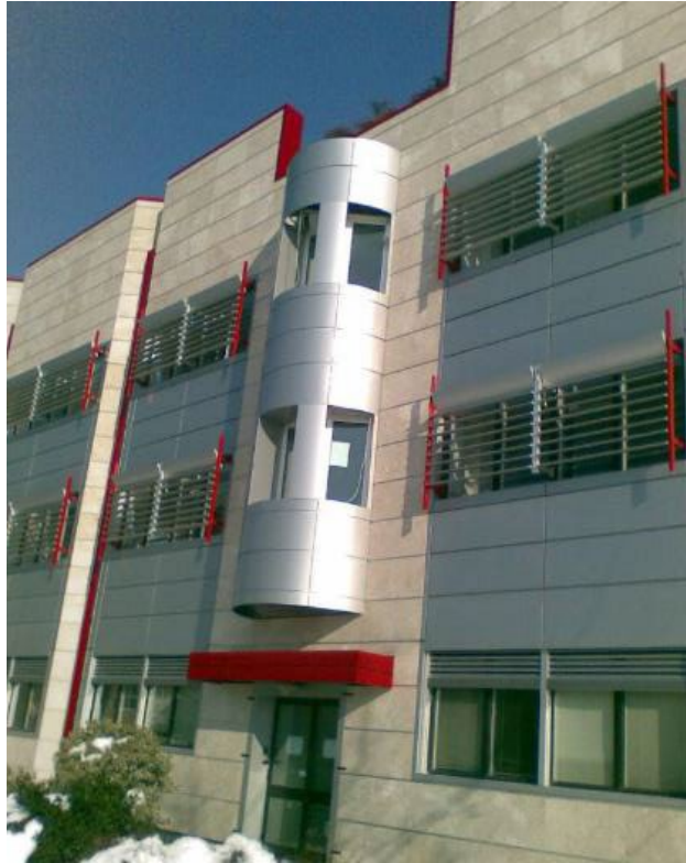
Coibentazione esterna con aggiunta di massa termica
